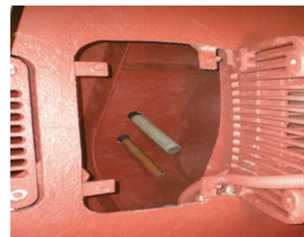
Esempio di installazione anodi nella presa a mare Anode installation example into a sea chest
