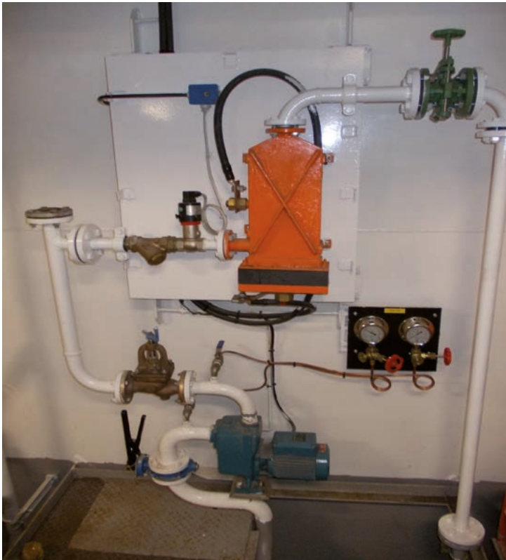
Gruppo di elettrolisi Electrolysis group
